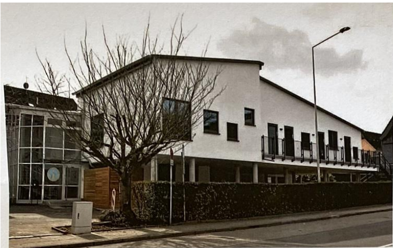
Der Anbau an das Katholische Familienzentrum St. Laurentius ist fertiggestellt. Am 23. April findet ein Tag der offenen Tür statt, bei dem die neuen Räumlichkeiten besichtigt werden können.
